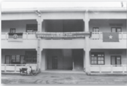
(Abb. 16) Unterkunft für Techniker auf der Baustelle BA VI, 1973
